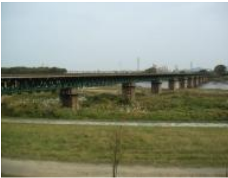
小俣側より見た鉄橋
